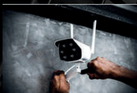
ΚΛΕΙΣΤΟ ΚΥΚΛΩΜΑ CCTV
